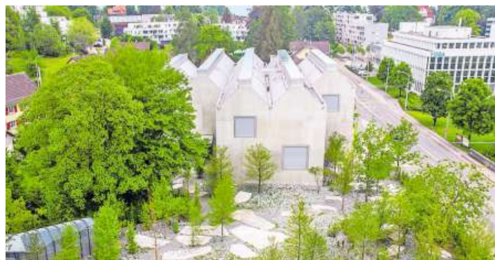
Wenn es nach der Interpellation geht, sollen die kahlen Betonfassaden des Naturmuseums grün werden.
