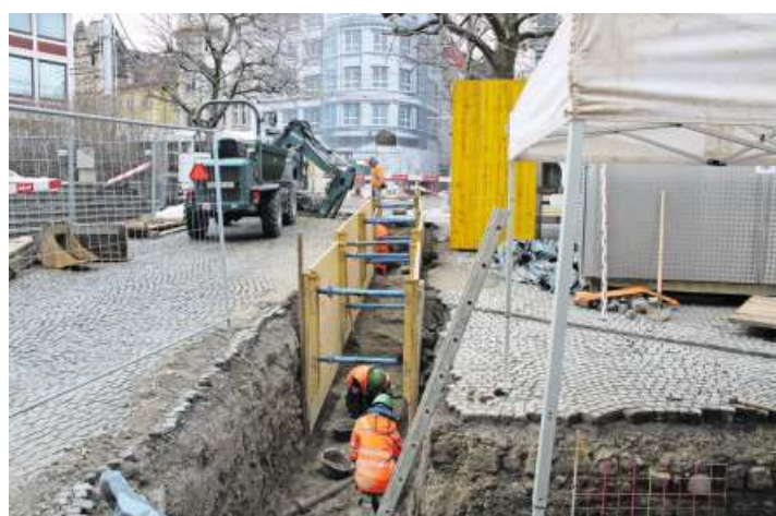
Der Graben führt nahe an der Platane vorbei. Die Arbeiten werden deshalb von einem Baumpfleger begleitet. Bild: Reto Voneschen
