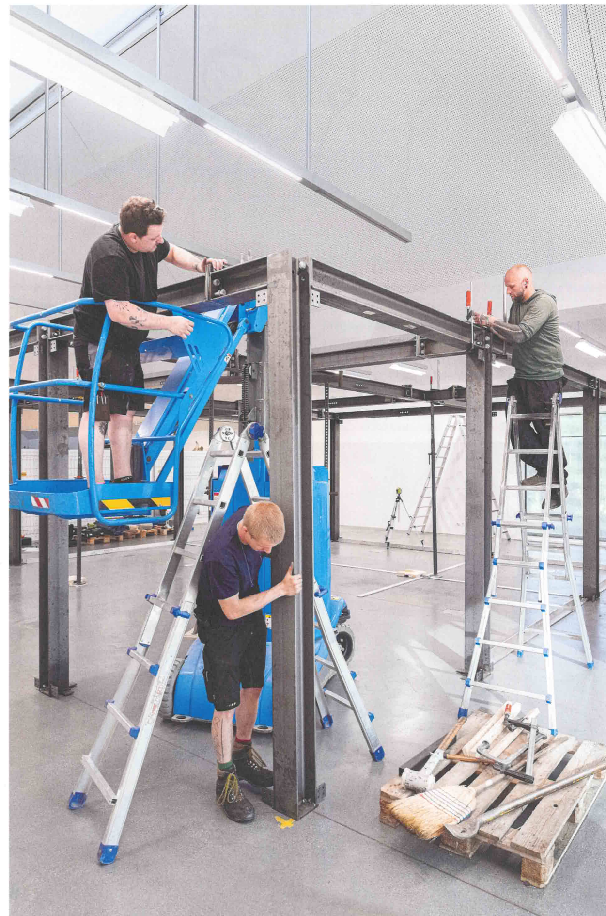
Der Aufbau der tonnenschweren Stahlkonstruktion für den Spiegelraum dauert zwei Tage.
