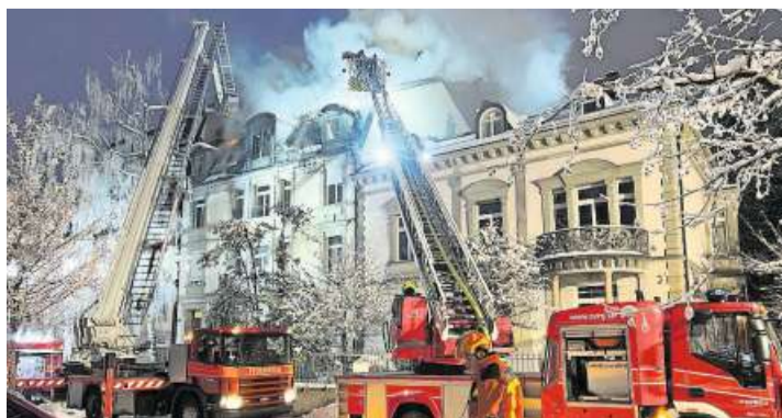
Am 14. Januar 2024 brach ein Brand im Dachstock eines Mehrfamilienhauses an der Blumenaustrasse aus. Bild: Stapo SG
